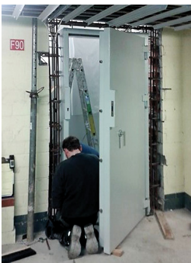
Ausrichtung und Fixierung der Tresortür im lichten Wandausschnitt
