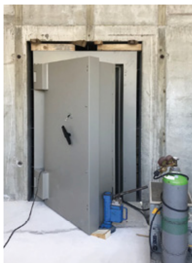
Installation der Tresorraumtür im lichten Wandausschnitt
