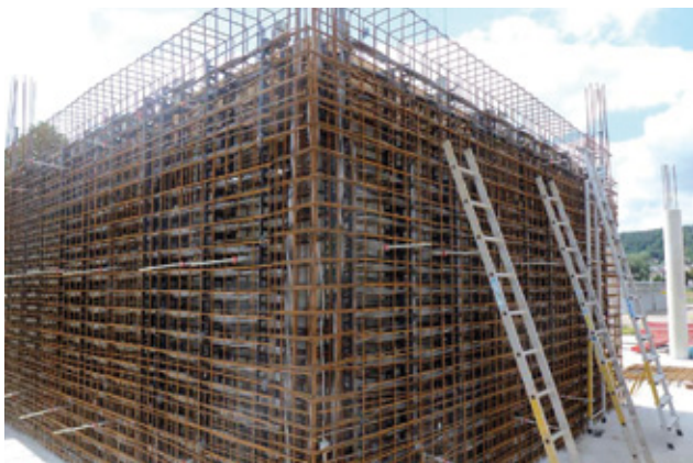
Montage der Sicherheitsarmierung in der Wand
