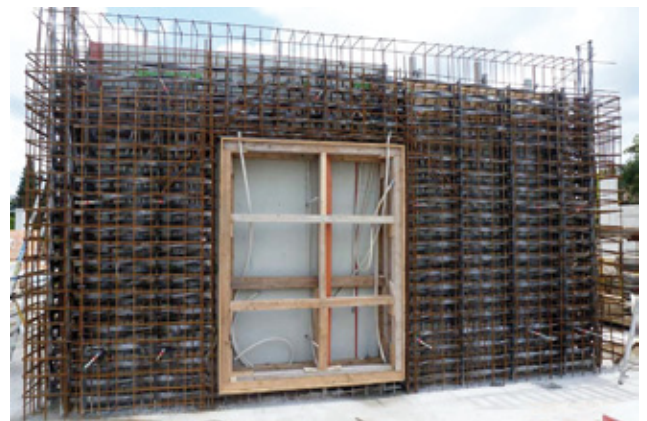
Montageansicht mit Öffnung für Wertschutzraumtür
